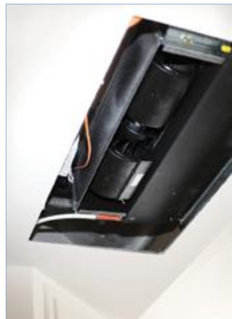
Рисунок 5. Центробежные ЕС-вентиляторы идеально подходят для фанкойлов
